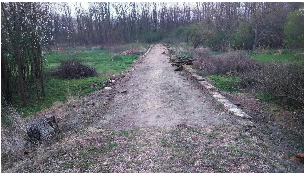
Obr. 9. Stav skrývky povrchu mostu 15. 4. 2019.
